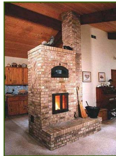
Un corps de chauffe en maçonnerie constitue souvent le point central de la maison.
